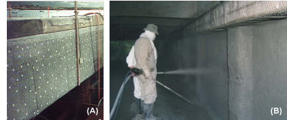
A - Fixação da malha com fixadores de plástico à superfície do concreto B - Aplicação por projeção a seco da camada de revestimento
